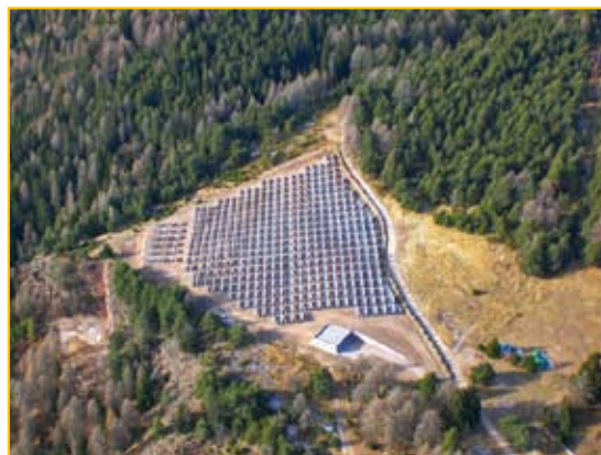
Fotovoltaico su ex cava di porfido a Carano (TN)
