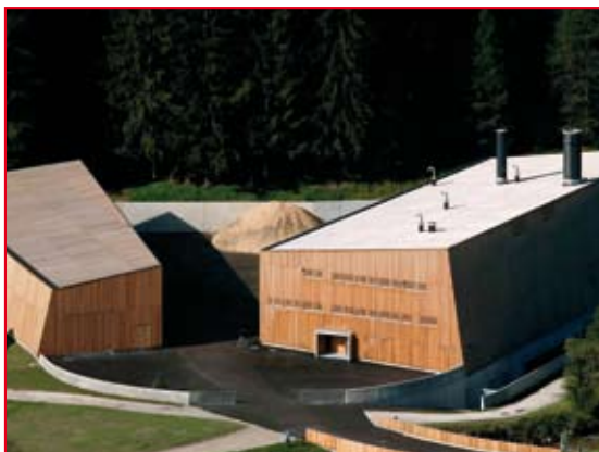
Impianto di teleriscaldamento da biomassa - Sesto (Bz)
